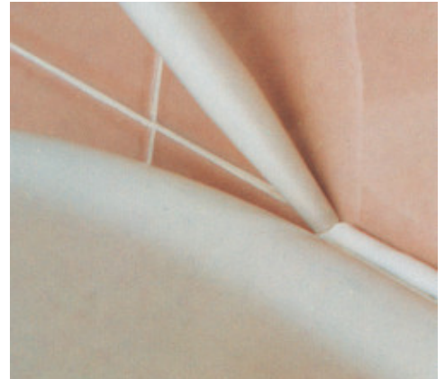
Afdichten van sanitair
